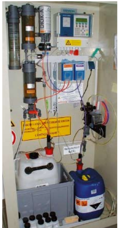
Bild 6: Chlordioxid nach dem Salzsäure-Natriumchloritverfahren
